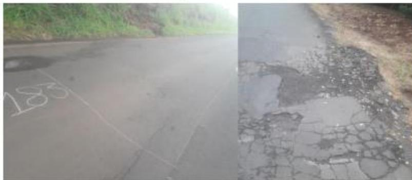
Na seção 07 o índice ficou de 205,52% na faixa direita e 228,14% na faixa esquerda, ambos classificados como péssimos, sendo os defeitos frequentes as trincas FC-01, desgastes, trincas FC-03 e afundamentos consolidados.
