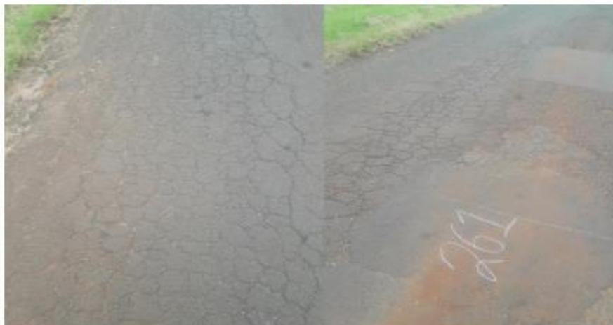
deformações causadas pela repetição do tráfego, dimensionamento incorreto das camadas e camadas saturadas (YOSHIZANE, 2005 Apud Silva e Silva, 2018).
