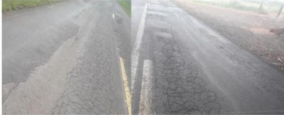
Conforme a Figura 03 é possível analisar o índice de gravidade global da quinta seção, no qual a faixa da direita teve um resultado de 161,13% e a faixa esquerda de 207,96%, ambas obtiveram classificação péssimas. Os defeitos mais frequentes neste trecho foram às trincas FC-01, afundamento consolidado e desgastes, conforme Figura 04.
