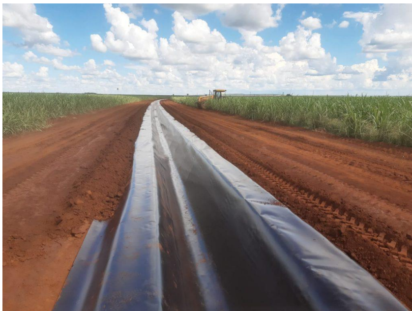
Figura 2 – Canal de vinhaça em PEAD. Usina Guaíra – SP. Fonte: B&B Soluções Ambientais (2021).
