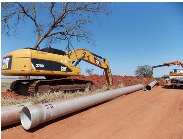
Figura 4 – Instalação de adutora de vinhaça pressurizada em tubulação de RPVC. Fonte: Irriga Engenharia (2021).
